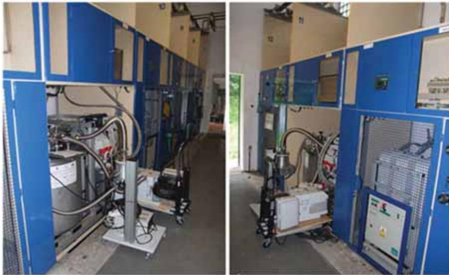
**Rys. 3.** Nadprzewodnikowy ogranicznik prądu zainstalowany w rozdzielni GS2 110 kV / 6 kV na terenie Instytutu Elektrotechniki
